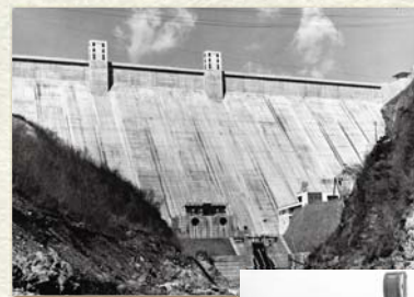
完成直後の小河内ダム
